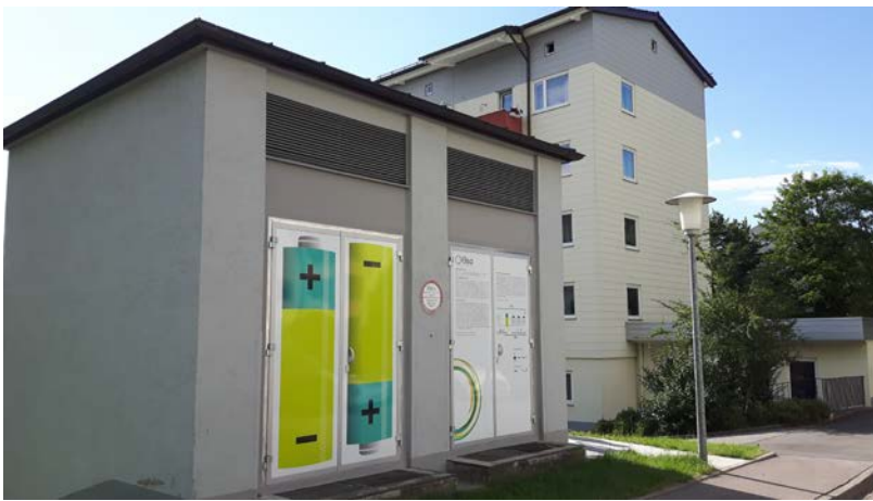
Abbildung 6: In diesem Gebäude in Kempten wurden im Rahmen des Projekts ELSA mehrere Second-Life-Batterien zusammengeschlossen. Der Speicher hat eine Kapazität von 66 kWh und hilft, das Wohnquartier mit Energie zu versorgen. Foto: eza!
